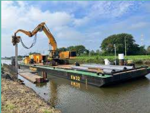
Hergebruikte stalen damwanden
